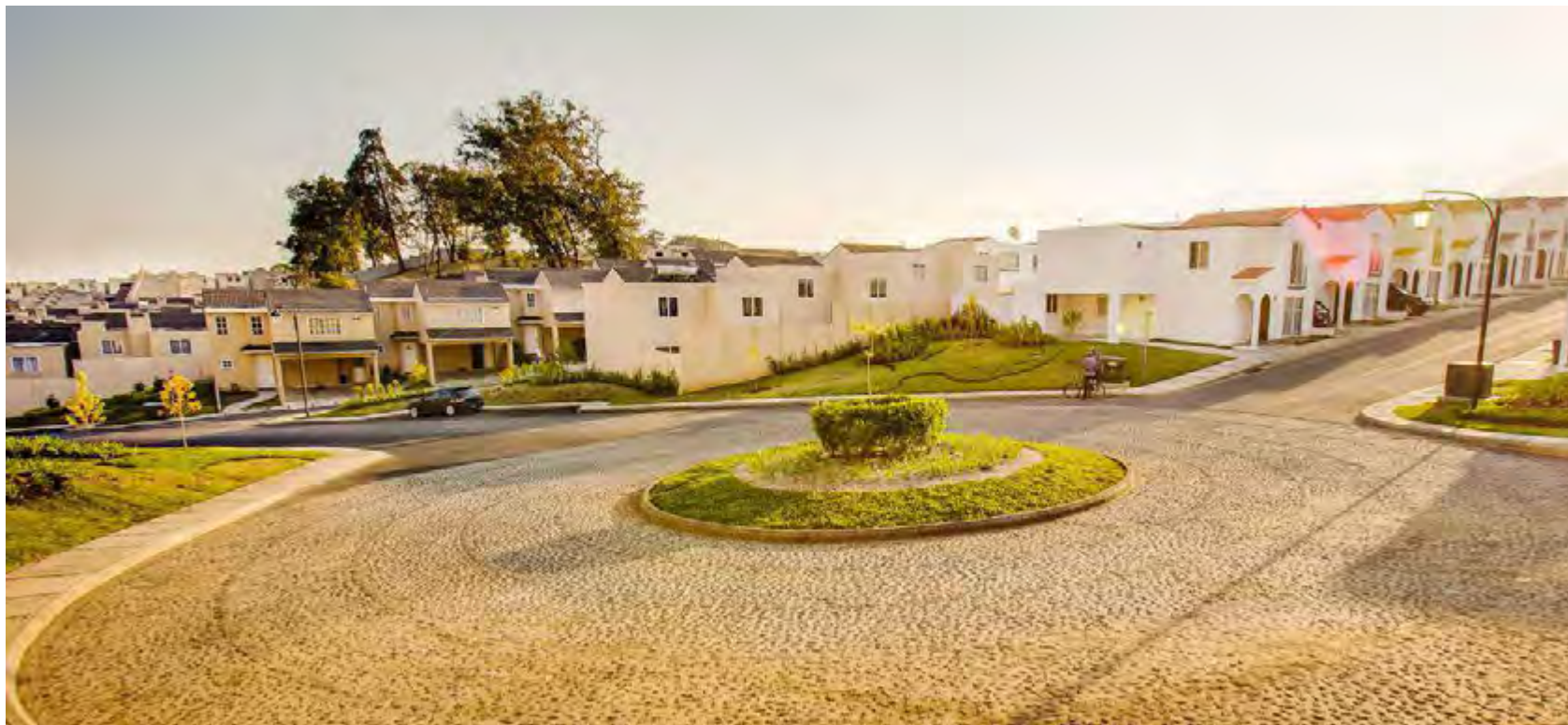
Proyecto habitacional Prados de San Cristóbal, Guatemala
